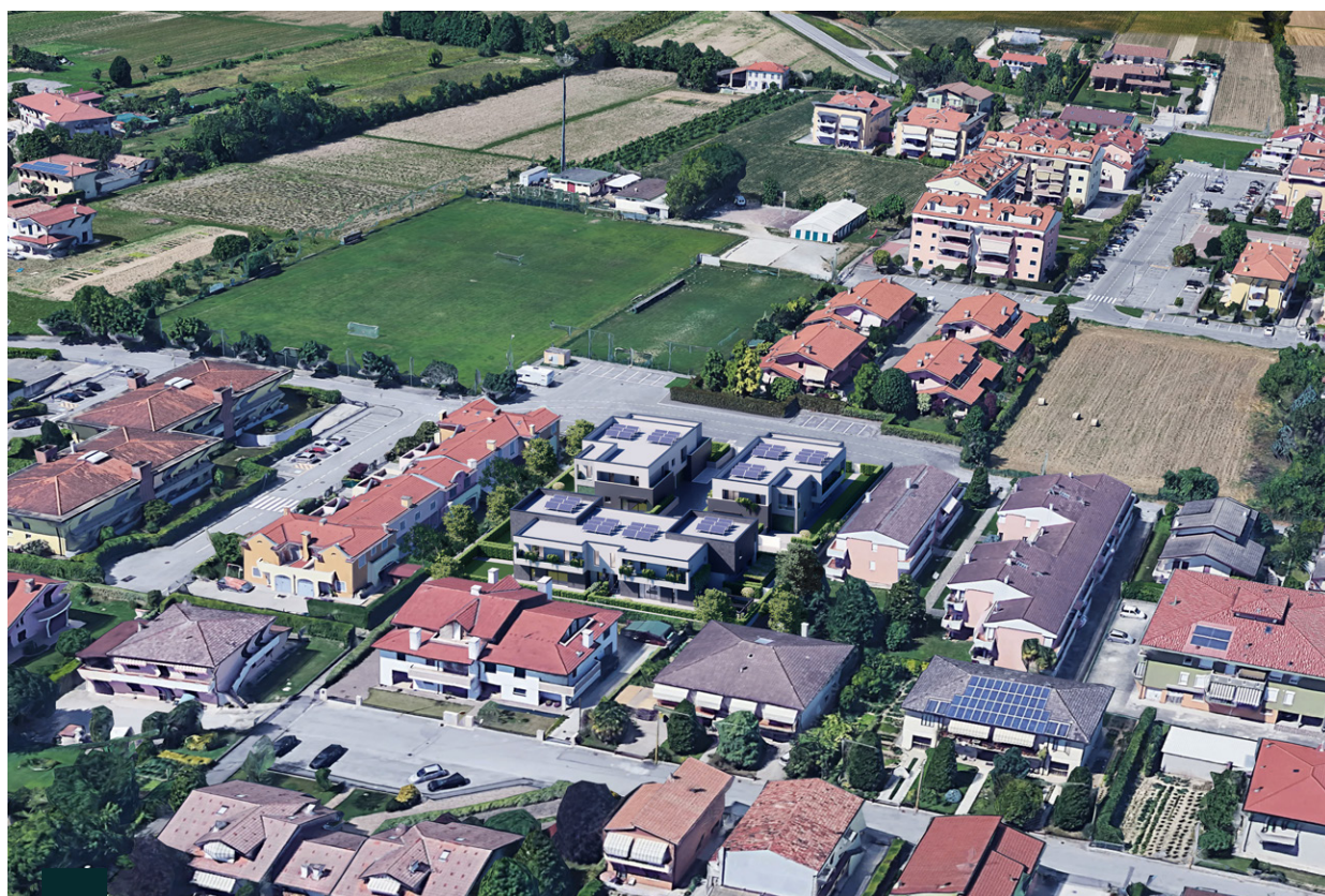
Veduta Sud dell'intervento
