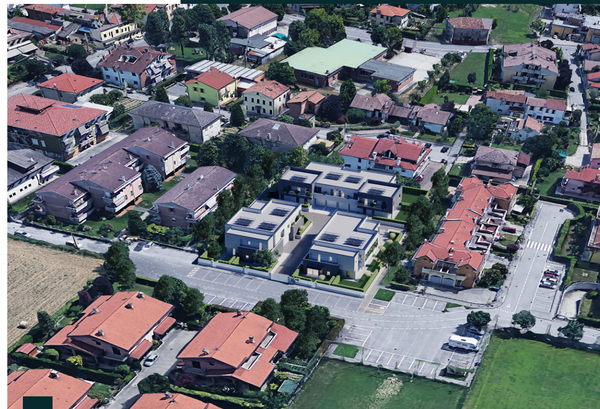
Veduta Nord dell'intervento
